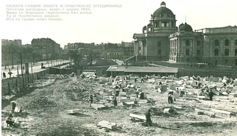
2. Поглед на простор који заузима данашња зграда на почетку изградње (разгледница из колекције Душана Напијала)
